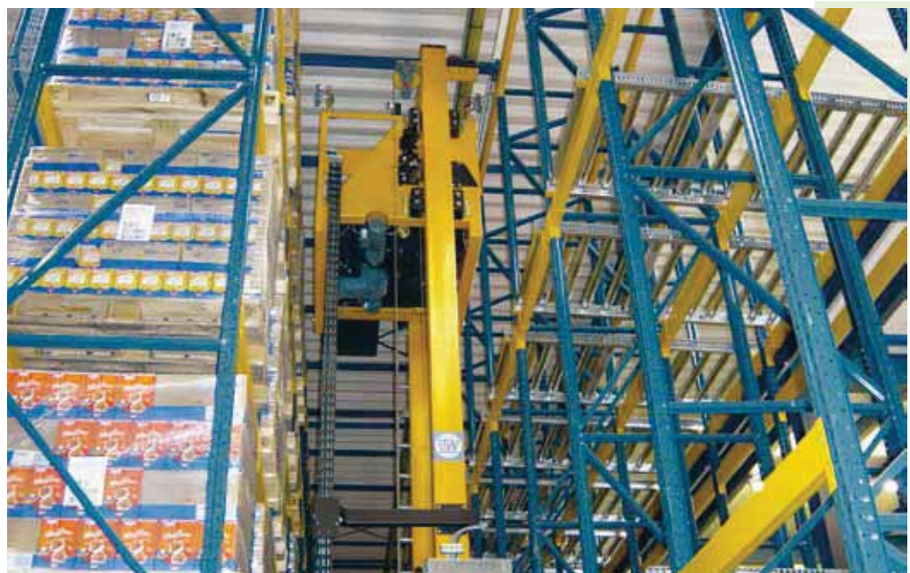
Vollautomatisches Kommissionierhochregal mit Regalbediengerät
